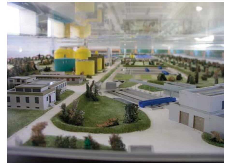
Modell der Anlage mit Blockheizkraftwerk, das über 90% des Strombedarfs des Klärwerks deckt
